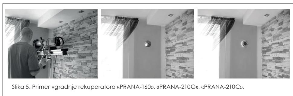
Slika 5. Primer vgradnje rekuperatorja «PRANA-160», «PRANA-210G», «PRANA-210C».
